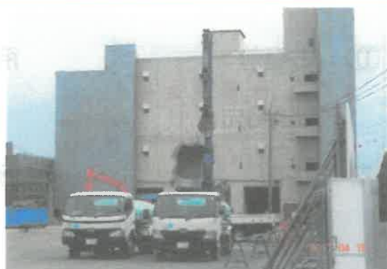
これからピークを迎える解体工事
